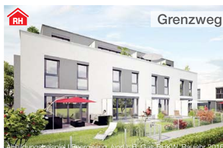
Abbildungsbeispiel | Energiegang, (vorl.): B, Gas/BHKW, Baujahr 2016
