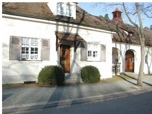
Verwaltungsgebäude Waldfriedhof – neuer Eingang
