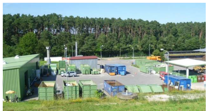
Groß und übersichtlich: Der neue Recyclinghof im Entsorgungszentrum
