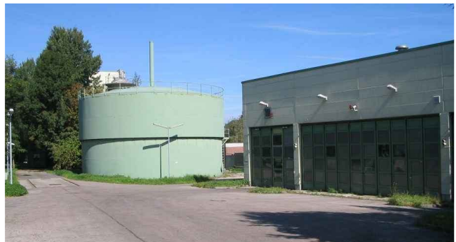
Zum 31. März 2010 verkauft: Die Bioabfallvergärungsanlage der Stadtdienste Schwabach GmbH an der Ecke Flur-/ Mühlenstraße
