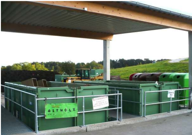
Ein Herzstück des neuen Recyclinghofs am EZS sind die „versenkten“ Container, die den Einwurf der am häufigsten angelieferten Abfälle (v.a. Altholz, Sperrmüll) nun erheblich erleichtern
