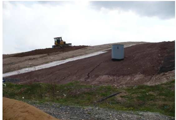
Bauarbeiten zur Aufbringung der temporären Oberflächenabdichtung am Entsorgungs-Zentrum-Schwabach (aufgenommen im April 2008). Mittlerweile ist im wahrsten Sinne des Wortes Gras über die Abdeckung gewachsen (vgl. auch Abb. S. 26 im Hintergrund).
