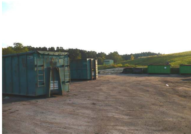
Neu geschaffene Umladefläche für Bioabfälle am EZS. Im Hintergrund ist ein Teil der temporären Oberflächenabdichtung der Deponie erkennbar.
