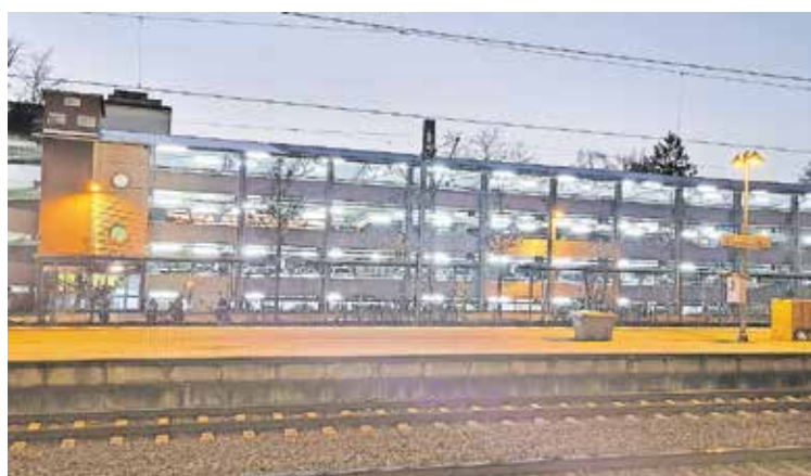
Auch an den Bahnsteigen am Bahnhof Schwabach wird gearbeitet.
