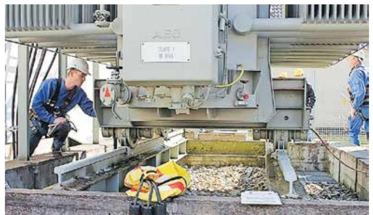
Oben: Der 26 Tonnen schwere Koloss im Schwebезustand. Unten: Der Trafo muss passgenau aufsetzen.
