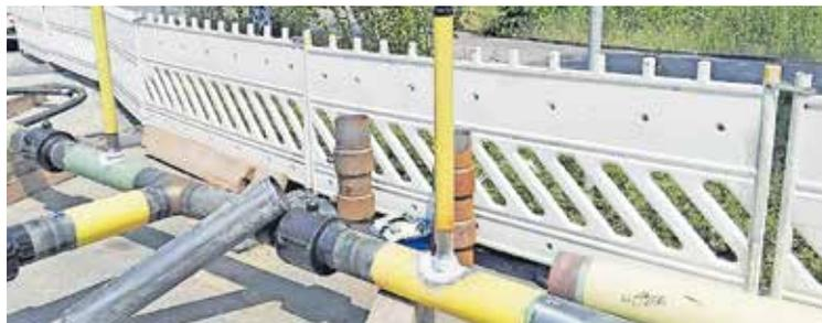
Oben links: Die Leitung wird mit sogenannten Sperrblasen abgedichtet. Oben rechts: Die Leitung im Bild musste ausgetauscht werden. Unten: Die Armaturengruppe wartet auf den Einbau in den Rohrgraben.
