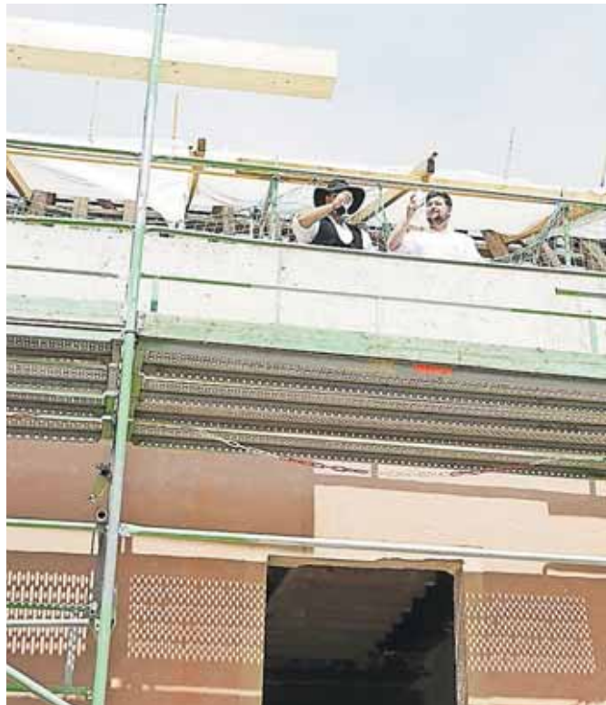
Mit dem Richtspruch feierten die Zimmerer das bisher Geleistete.
