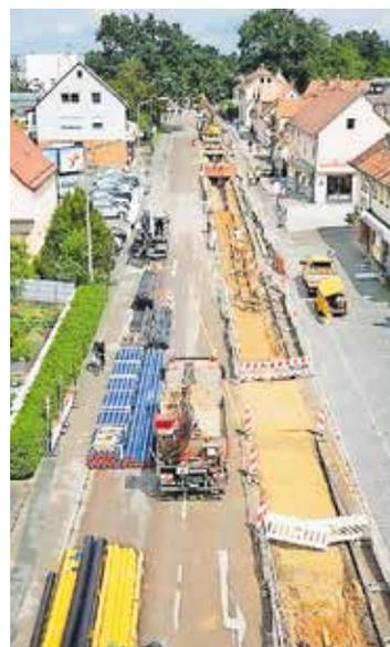
Das Baufeld von oben: Anfang September wurde der Strom-, Gas- und Wasser-Leitungstausch abgeschlossen und eine neue Asphaltdecke aufgetragen.
