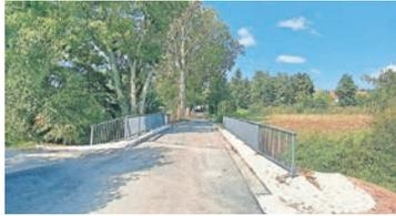
Nach Brückenbauarbeiten kann nun der westliche Arm der Volkachstraße wieder befahren werden. In der Zeit von März bis September wurden durch das Tiefbauamt die bau-fälligen Brücken abgebrochen und durch Neubauten ersetzt. Die Gewichtsbeschränkung für Fahrzeug über 3,5 t konnte somit wieder aufgehoben werden. Auf dem östlichen Arm der Volkachstraße bleibt die Brücke über die Schwabach weiterhin für den Kraftfahrzeug-Verkehr gesperrt. ■
