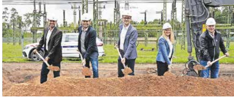
von links: Jörg Zimmermann (N-ERGIE), René Lukas (Stadtwerke), OB Peter Reiß, Wirtschaftsreferentin Stefanie Rother und Horst Humpenöder (Baufirma) beim offiziellen Spatenstich für das neue Umspannwerk
