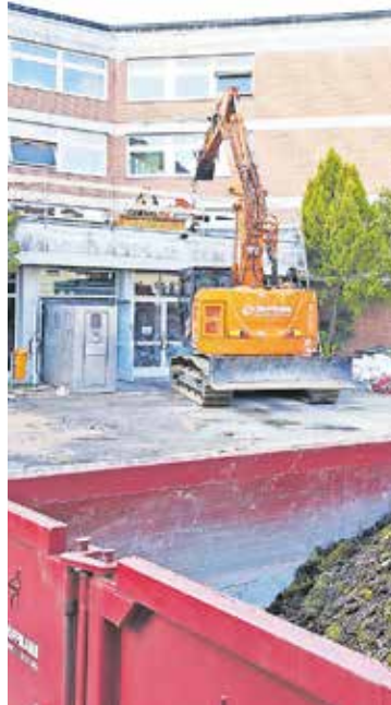
Der Abriss des Dachaufbaus im Eingangsbereich
