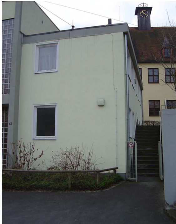
Ansicht Nord / Treppe
