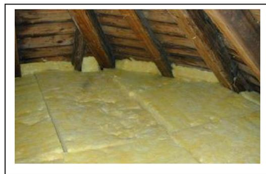
Bild 16: Dämmung des Spitzbodens
