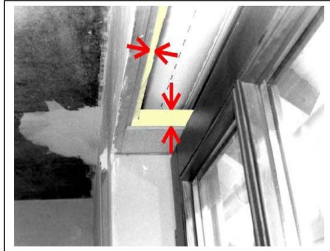
Bild 14: Dämmung des Rollladenkastens
