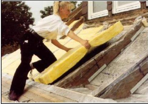
*Bild 17: Zwischensparrendämmung von der Dachseite*
