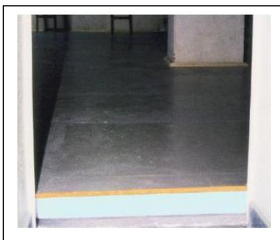
Bild 15: Dämmung des unbeheizten Dachboden
