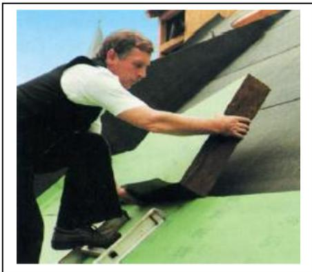
*Bild 18: Aufsparrendämmung*
