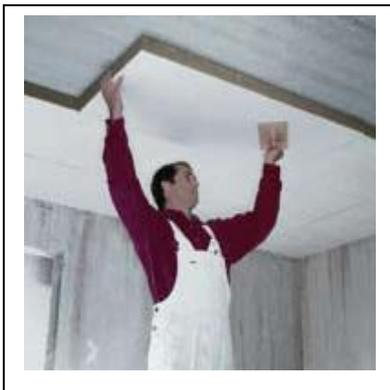
Bild 12: Dämmung der Kellerdecke
