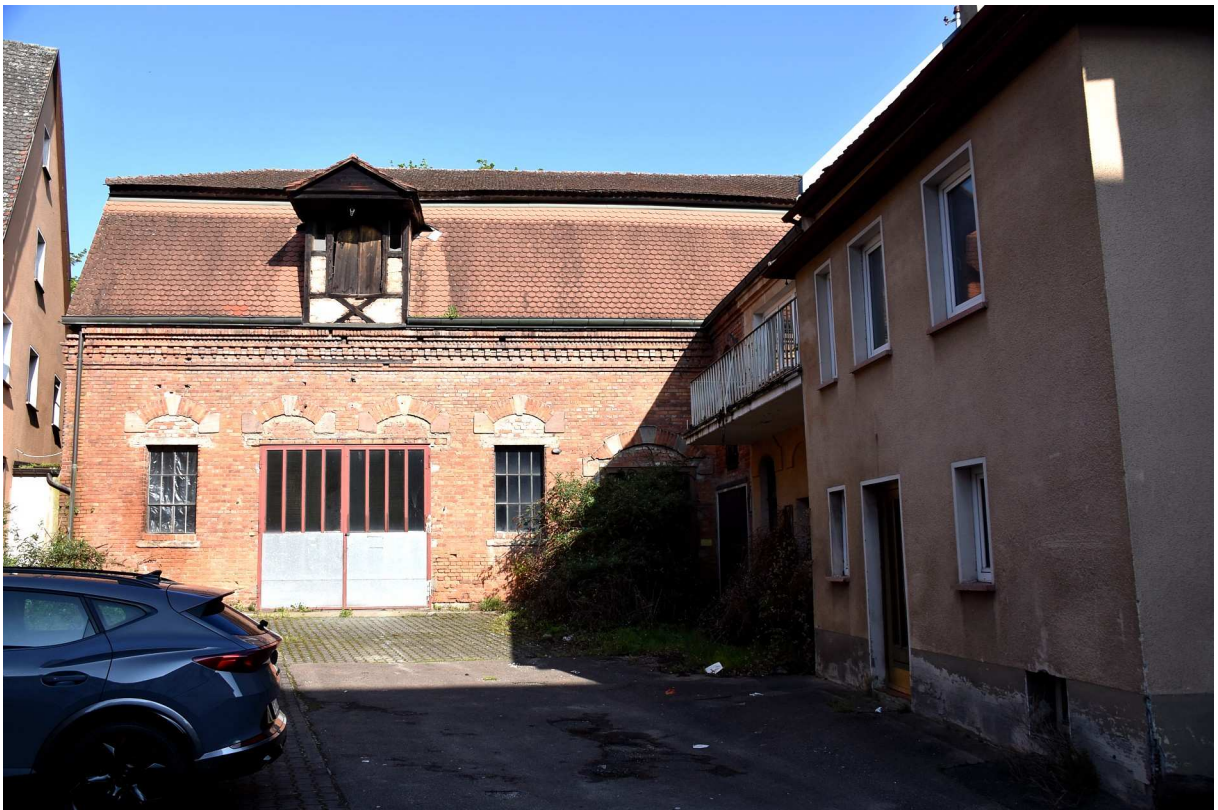
Abb. 2: Ansicht Alte Mälzerei Zöllnertorstr. 10a von Osten, bleibt erhalten (Foto FEHSE 03.05.2023)
