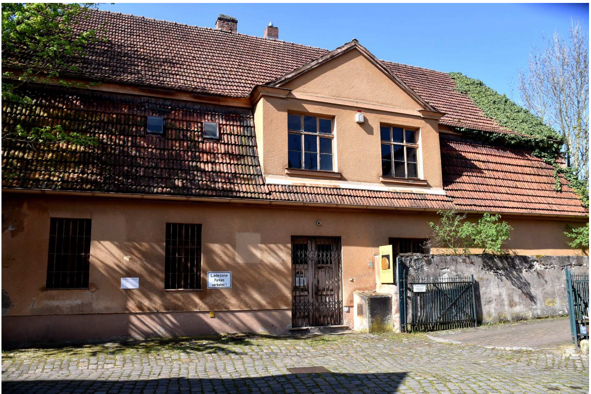
Abb. 4: Anwesen Südl. Mauerstr. 7b, soll abgebrochen werden (Foto FEHSE 03.05.2023)
