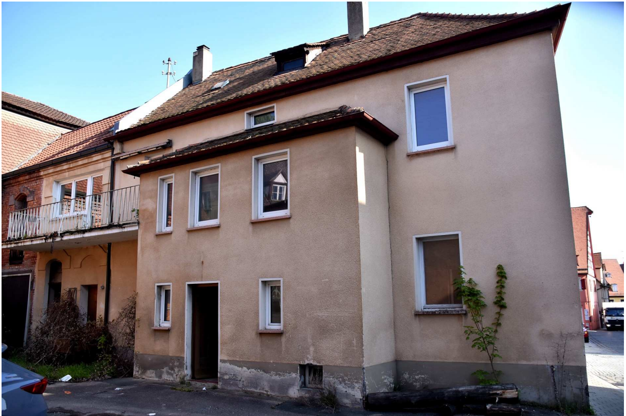
Abb. 3: Ansicht Vorderhaus Zöllnertorstr. 10a, soll abgebrochen werden (Foto FEHSE 03.05.2023)
