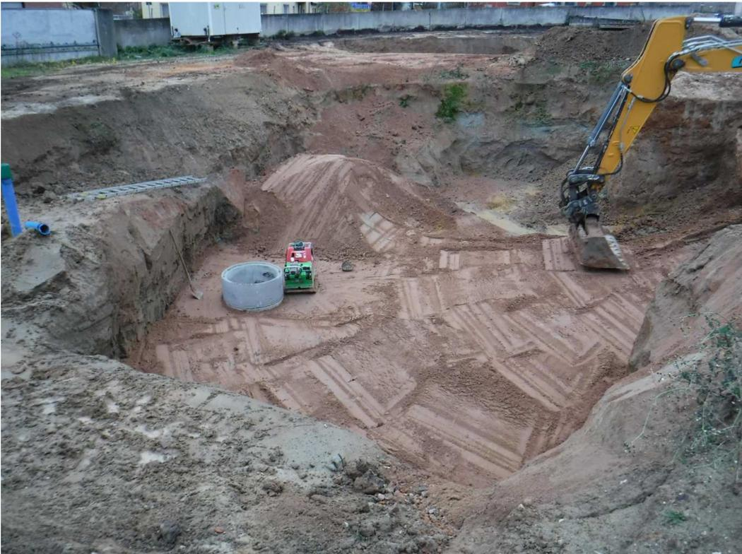
Abb. 43/44 Fläche F 5, Verfüllung Blick nach SW, zur Trockenhaltung der Sohle wurden Schachtringe eingebaut (20./24.11.2017)
