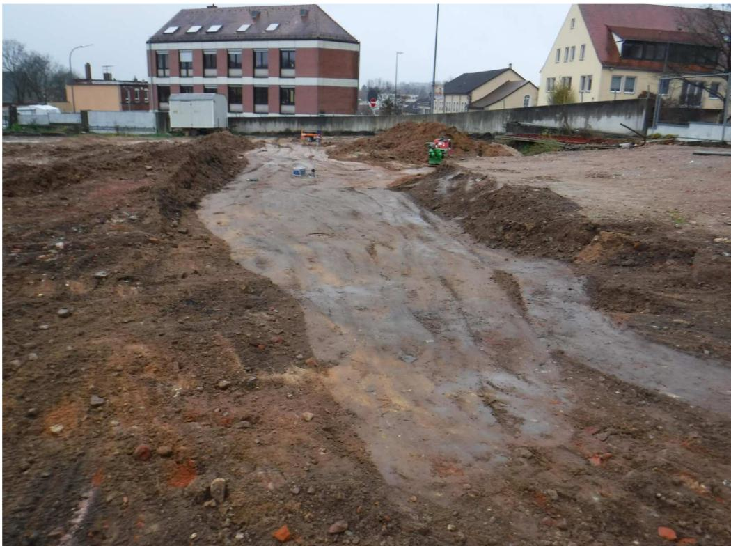
Abb. 42 Sondiergraben West wieder verfüllt (24.11.2017)
