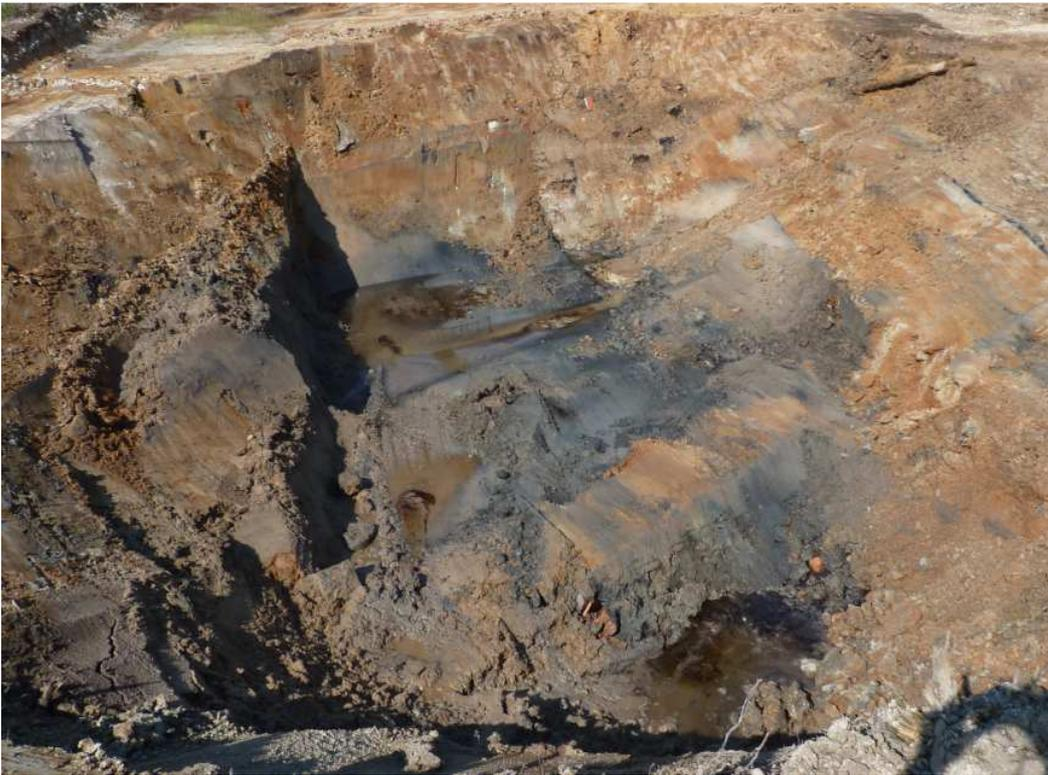
Abb. 17 Fläche 5 flächige MKW Belastung Blick SE (20.06.2017)
