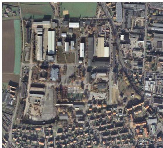
Orthofoto 46 Nördlich der Abenberger Straße
